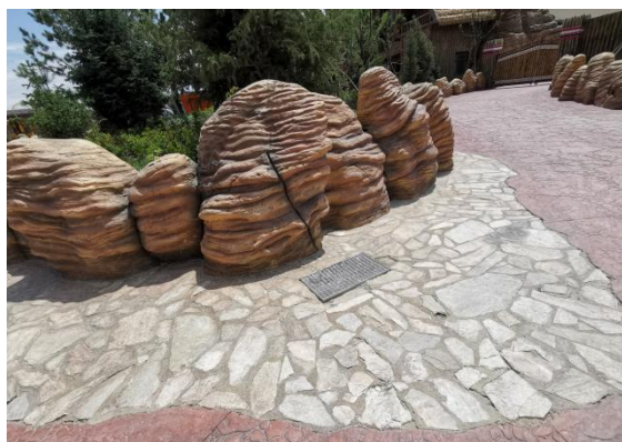
区域内雨水排水井
