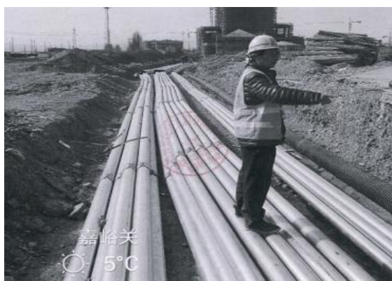
雨水排水管安装
