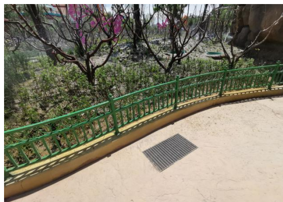
区域内雨水排水井
