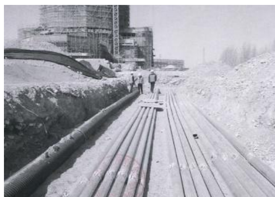
雨水排水管安装
